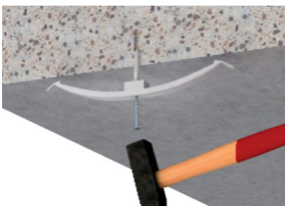
Inslaan in plafond
