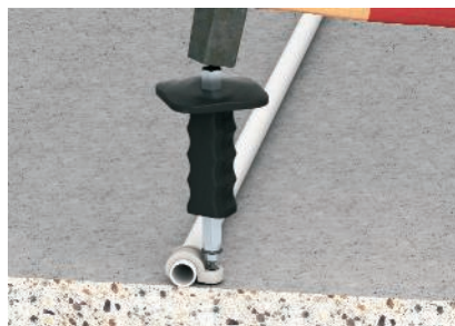
Mit dem Setzeisen einschlagen
