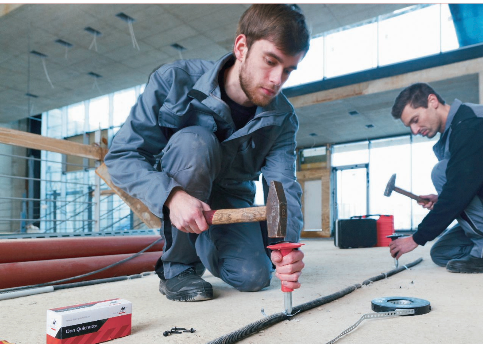
Fixation et maintien- Fixpin, outil de pose et bande perforée
