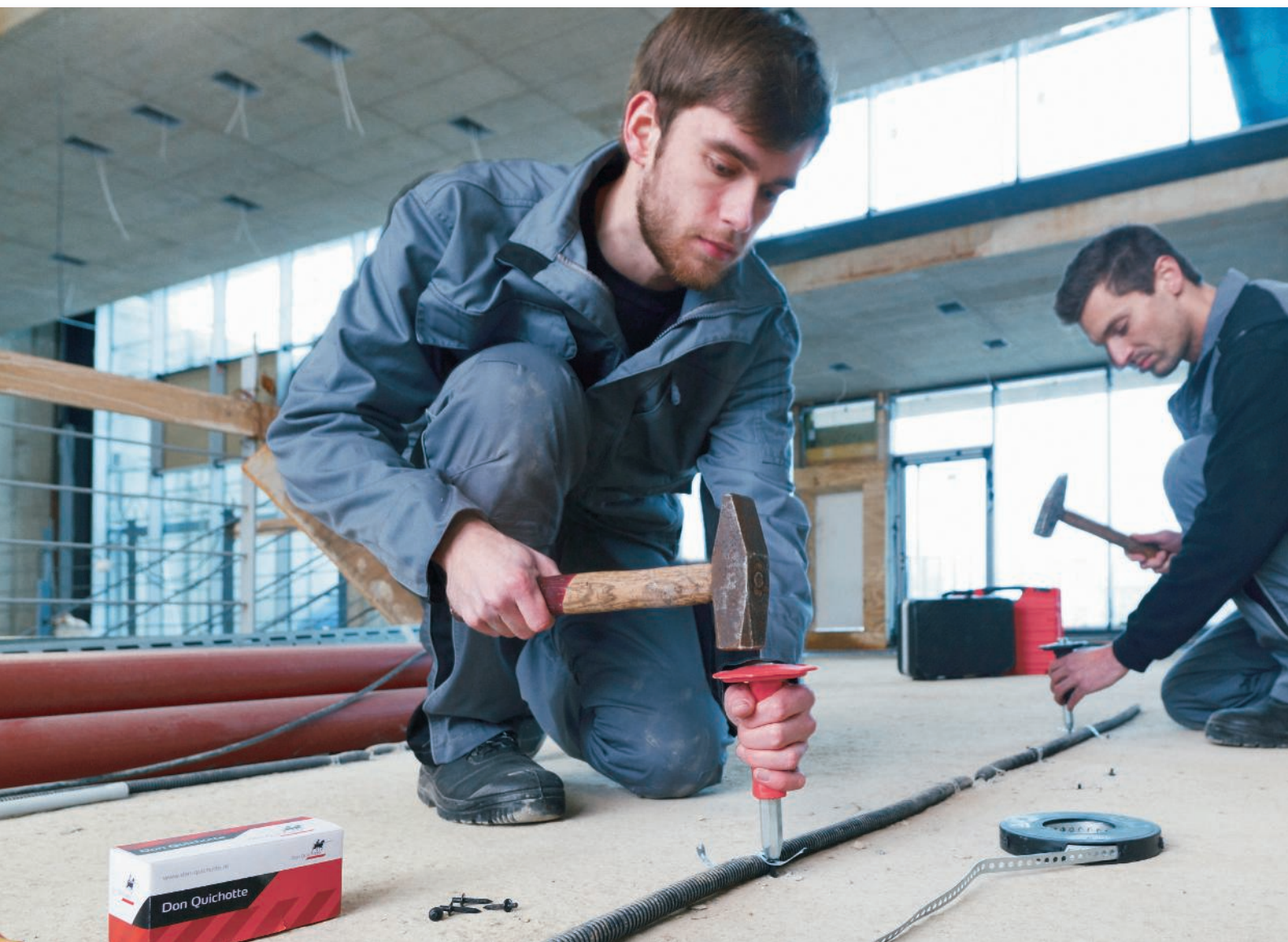
Bevestigen en fixeren, bijv. met de FixPin, Slagijzer en Montageband.
