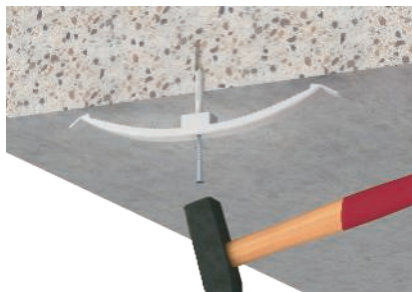
Inslaan in plafond
