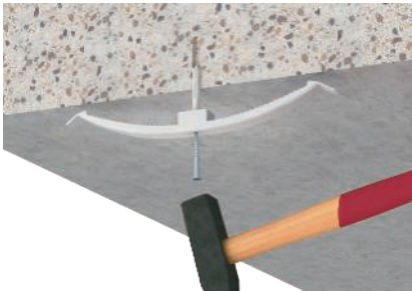
Frapper en plafond
